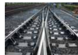
分岐器PCマクラギ
