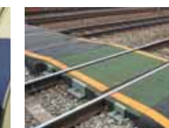
発生軌道パッドの踏切路盤材化
