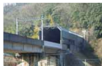
トンネル緩衝工
