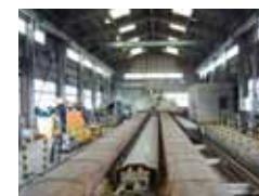
レール再生プラント
