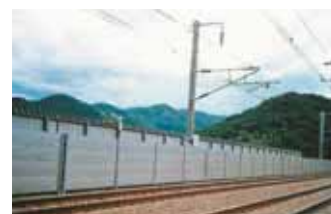
新幹線防音壁・吸音板
